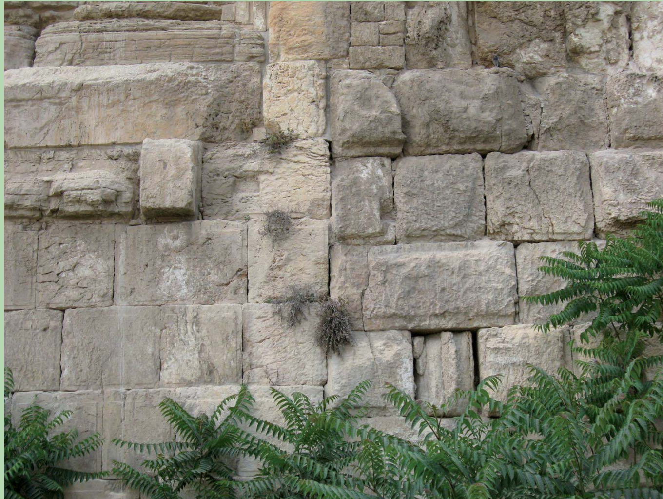
קו "התפר" בחומה המזרחית בין הבנייה הקדומה באבני גזית גדולות בעלות גבנון, בצד ימין, לבין הבנייה המאוחרת יותר באבנים חלקות, משמאל. האבנים הגדולות משמאל הן שרידי שערים
